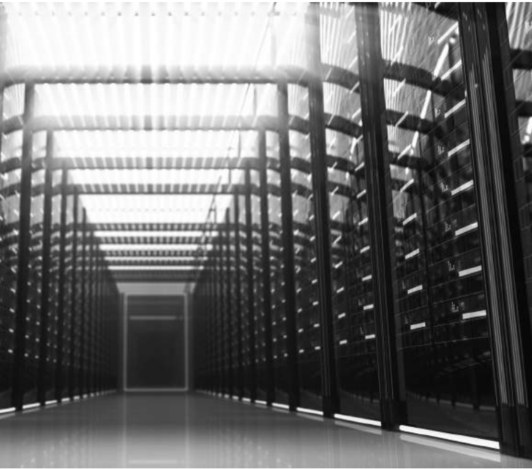
El control de este parámetro es un aspecto importante, dado que el calor es uno de los principales enemigos de los sistemas electrónicos
